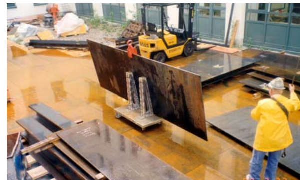
Bauen im Bestand
